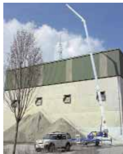
Strohmeiers K20-30TS kurz vor dem Einsatz bei der FBB in Pfäffikon ZH.
