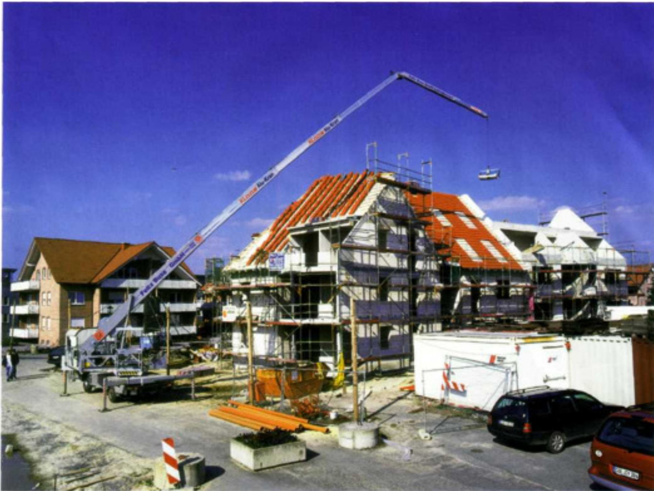
Dank der enormen Reichweite bei leichten bis mittelschweren Gewichten revolutionierten die Klaas Alu-Krane die Dachdeckerarbeit. Im Bild der K28-34 im Baustelleneinsatz.
